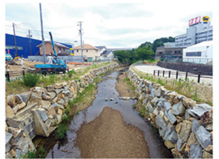
< 整備中の香流川上流水域 >
